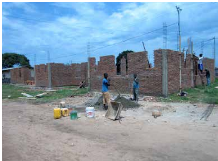
Строительство здания СЛС в Бурунди
